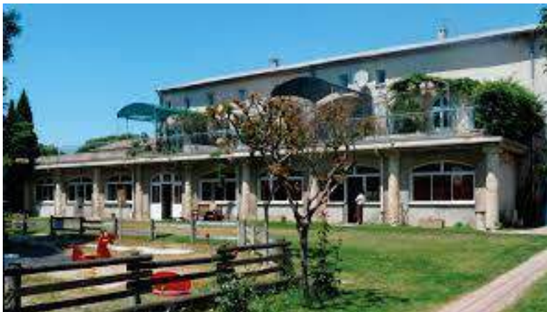
Bâtisse vue de l'intérieur de l'IME
